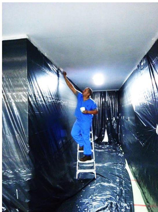
Depois – Teto Bloco Cirúrgico
