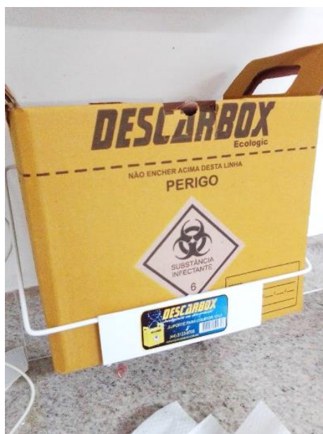
Instalação das caixas de perfuro cortante
